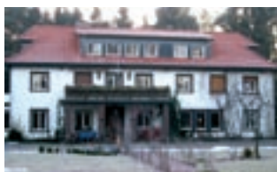
Das Resultat nach Bauabschluss: 70% Energie-Einsparung nach der Sanierung von Fassade, Dach, Fenstern, Heizung!
