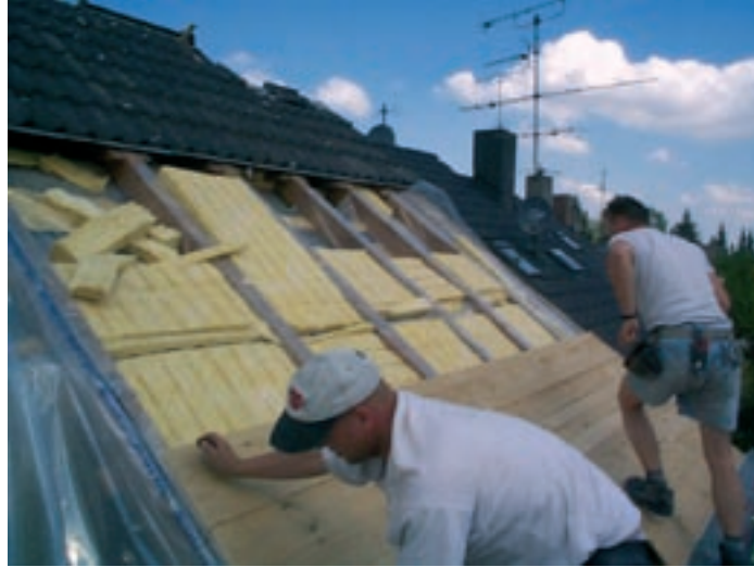
Heute muss ein Dach mehr können als nur Wasser abhalten
